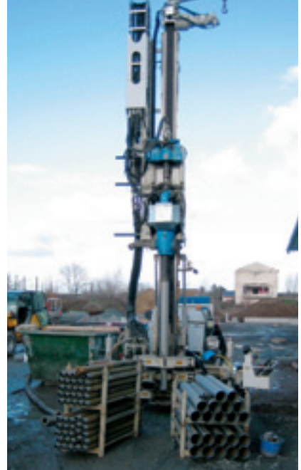
Abb. 7 links: Erdwärmesonden-Bohrung in Gneis mit Imloch-Hammer, in einer Baugrube im Schutz einer Bohrpfahlwand; rechts: das gleiche Bohrgerät rund 25 km entfernt, Spülbohrung mit Hilfsverrohrung in tertiären Sedimenten.
