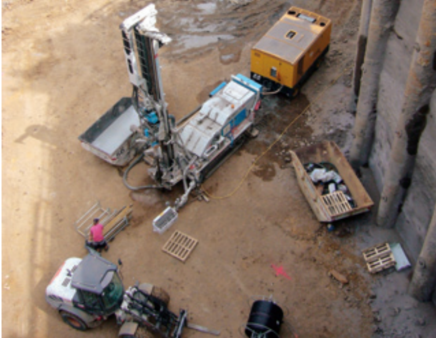
Abb. 7 links: Erdwärmesonden-Bohrung in Gneis mit Imloch-Hammer, in einer Baugrube im Schutz einer Bohrpfahlwand; rechts: das gleiche Bohrgerät rund 25 km entfernt, Spülbohrung mit Hilfsverrohrung in tertiären Sedimenten.
