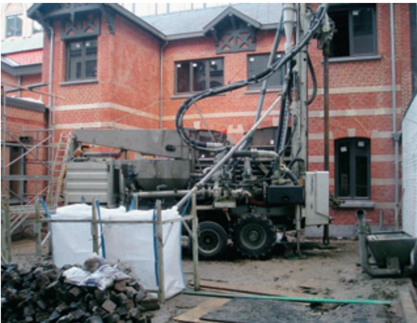
Abb. 11 Bohrarbeiten für die Erdwärmesonden im Innenhof des Renewable Energy House, Brüssel (Nov. 2005)
