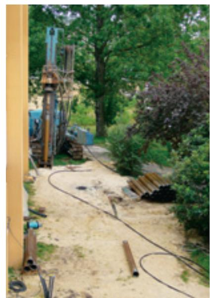
Abb. 9 Bohrarbeiten für Erdwärmesonden an der Escola Superior Tecnologia in Setubal, Portugal (Mai 2007)
