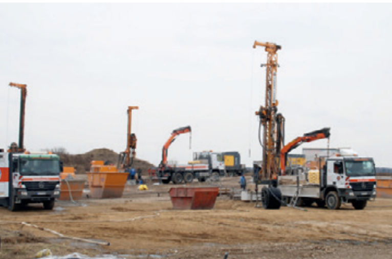
Abb. 4 – Erdwärmesonden-Bohrungen durch die Terra Therm Erdwärme GmbH, gleichzeitig mit drei Bohrtrupps (Februar 2012)
