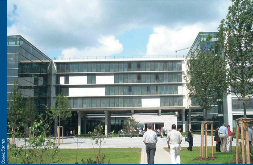
Abb. 4 Das Niedrigenergie-Bürogebäude der Deutschen Flugsicherung in Langen ist ein typisches Beispiel für einen Grundlast-Betrieb.
