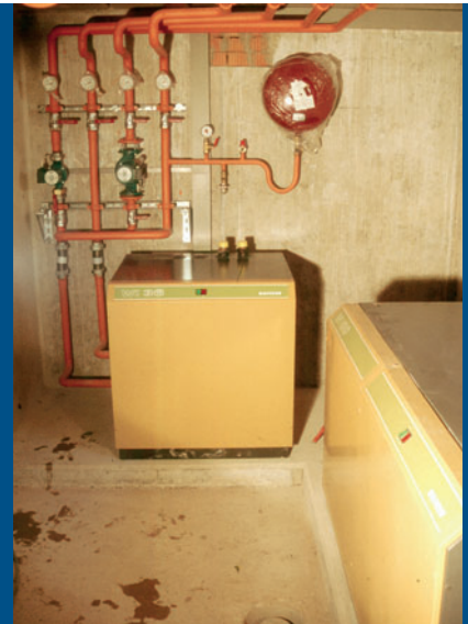
Abb. 3 Die 1991 gebaute Wohnanlage der damaligen Bayernwerke (links) war das erste größere Gebäude in Deutschland, das mit einer Erdwärmesondenanlage von über 100 kW ausgestattet wurde. Insgesamt sechs Wärmepumpen erbringen eine Gesamtleistung von 210 kW (rechts).
