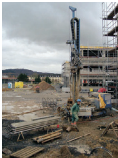
Abb. 3 Insgesamt wurden 32 Bohrungen auf dem Gelände in Wetzlar-Spilburg durchgeführt. Das Erdwärmesondenfeld erweitert sich in Richtung des Erdhügels im Hintergrund.
