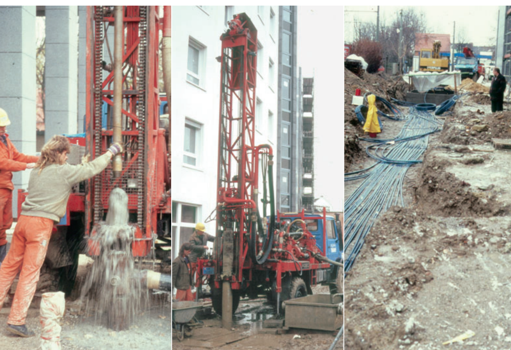
Abb. 2 Die Erdwärmesondenbohrungen in Frankfurt-Hoechst wurden durch den dort bestehenden artesischen Druck im tertiären Kalkstein-Aquifer erschwert. An der ersten Bohrung (1998) (links) kam es zu artesischem Wasseraustritt. Das Bohrloch wurde daraufhin aufgegeben (Mitte). Nach Verdoppelung der Sondenanzahl und Begrenzung der Länge auf jeweils 50 Meter konnten die Arbeiten fortgesetzt werden. Die Verbindung der Rohre stellte eine erneute Herausforderung dar (rechts).
