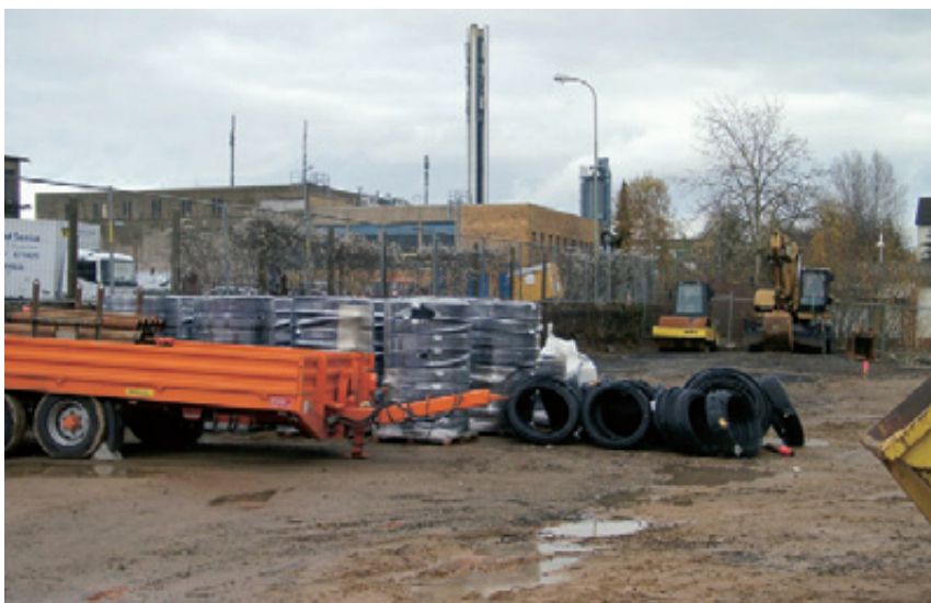
Abb. 4 Die industriell gefertigten Erdwärmesonden wurden in Rollen auf das Gelände Wetzlar-Spilburg geliefert.
