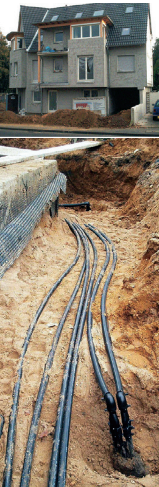
Abb. 10 Das Mehrfamilienhaus wird über sieben Erdwärmesonden versorgt, die über einen zentralen Verteiler mit dem Gebäude verbunden sind. Außenansicht (oben) und Kopf einer Erdwärmesonde mit Verbindungsrohren (unten)
