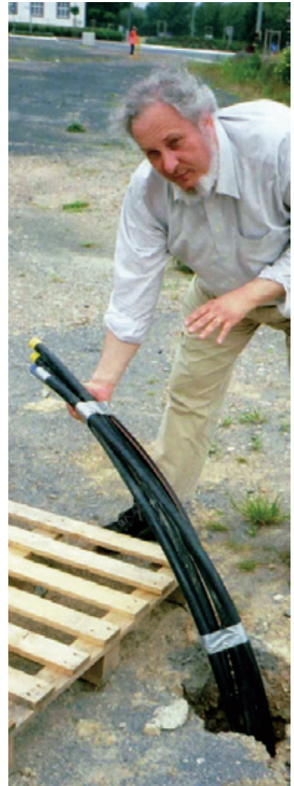
Abb. 1 Probebohrungen mit Erdwärmesonde in Wetzlar-Spilburg, bereit für den „Thermal Response Test“.
