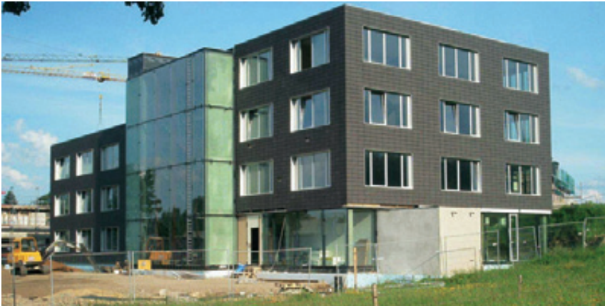
Abb. 7 Im Bürogebäude Vika in Aachen werden die Räume über Betonkernaktivierung mit Kühlung und Heizung versorgt. Im Vordergrund des Gebäudes ist das Erdwärmesondenfeld zu sehen.
