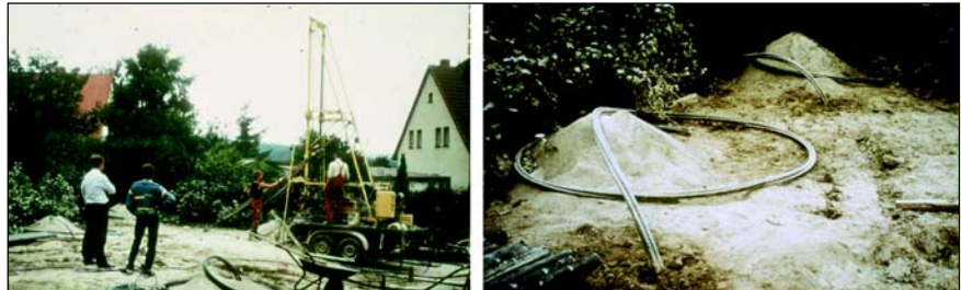
Abb. 3: Bohrarbeiten mit einfachem Gerät und fertig eingebaute Doppel-U-Sonden (insgesamt 6 x 50 m) in einem externen Standort des im Text genannten FuE-Vorhabens bei Göttingen, 1987 (Photos Sanner)
