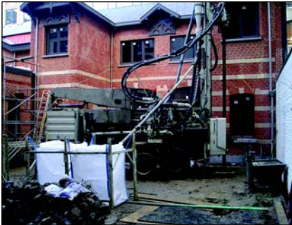
Abb. 4: Bohrarbeiten im Hof des Renewable Energy House, 18.11.2005 (Photo: Dumas)
