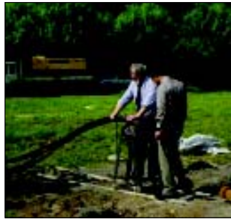
Abb. 6: Einbau der Erdwärmesonden über eine provisorische Einbringhilfe (Ende April 2003)
