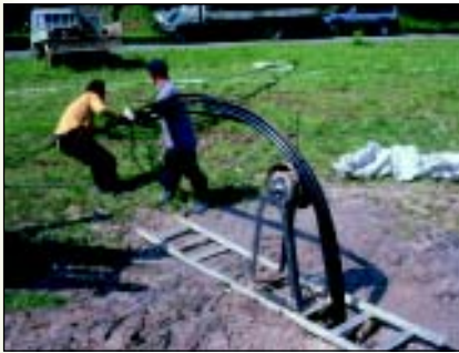
Abb. 6: Einbau der Erdwärmesonden über eine provisorische Einbringhilfe (Ende April 2003)
