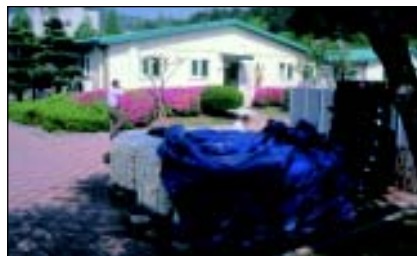
Abb. 4: Gebäude der HP System Tech in Daejon mit für den Einbau bereitliegenden Erdwärmesonden und Verpressmaterial
