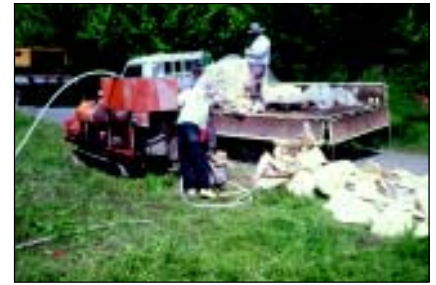
Abb. 7: Misch- und Pumpgerät für die Verpressung mit ThermoCon-tact
