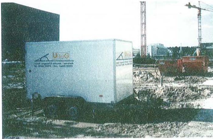
Abb. 2: Anhänger mit Gerät für Thermal Response Test im Einsatz
