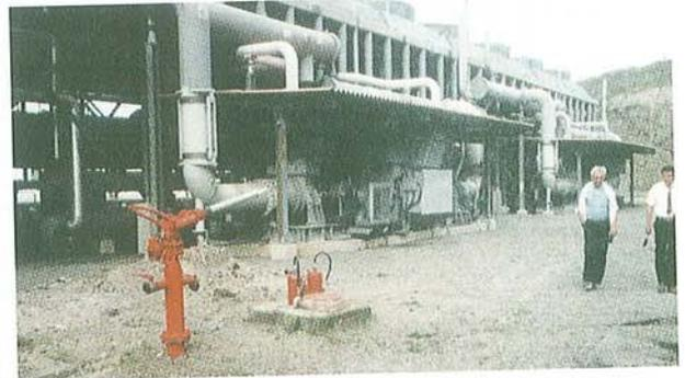
Abb. 4: Geothermische Zentrale Ribeira Grande, Blick auf die zwei Turbinen der Ausbaustufe A von 1994 (je 2,5 MWe); vorne links eine Feuerlöschkanone
