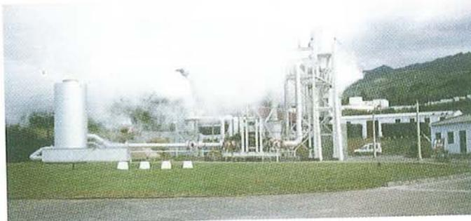
Abb. 2: Geothermisches Kraftwerk Pico Vermelho auf der Azoren-Insel Sao Miguel, 800 kW elektrische Leistung
